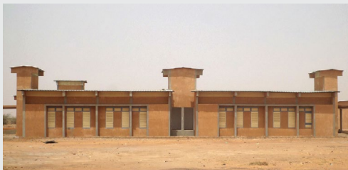
Cheminées solaires, Coopération luxembourgeoise au Niger
