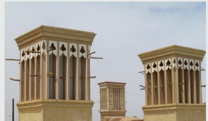
Refroidissement bioclimatique, baghirs, Iran
